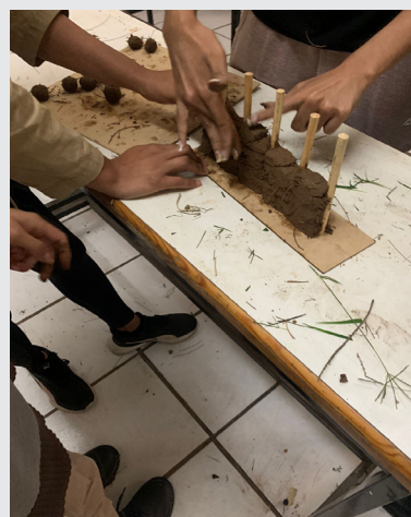
Figura 7: Construcción de muro COB.
